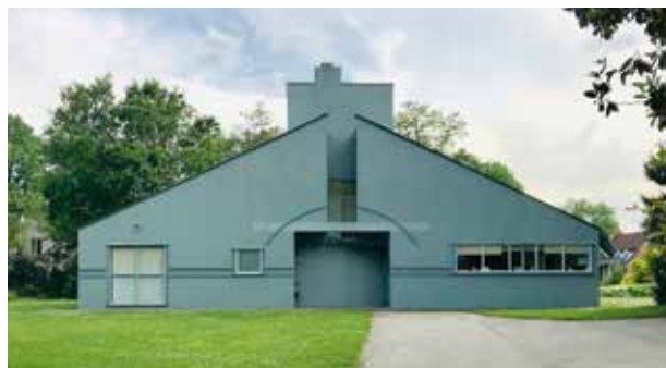
Das «Vanna Venturi House» in Philadelphia von Robert Venturi, 1964. Das Haus bekam 1967 einen frischen Anstrich.
