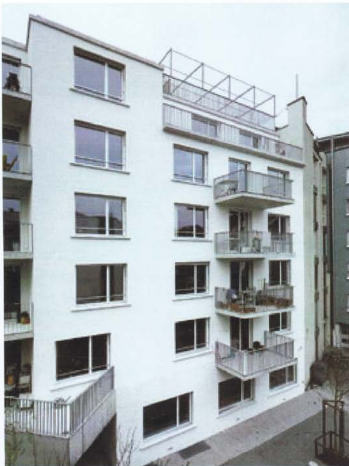
In diesem sechsgeschossigen Neubau entstanden insgesamt zehn Wohnungen und zwei Gewerbeeinheiten.
