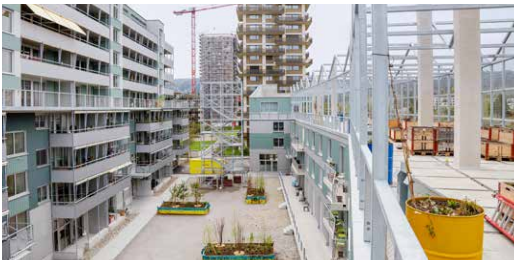
Eine grosszügige Dachterrasse steht den Bewohner:innen zur Verfügung. Die verglaste Pergola erinnert an die Gärtnerei, die früher auf dem Areal war.
