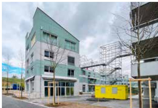
Den Eingang zum Hof bildet ein verdrehter Kopfbau. Im Erdgeschoss empfängt ab dem Sommer eine Bäckerei Kundschaft.
